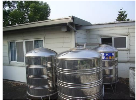
蒐集雨水再利用，可澆灌操場草地，有效紓解用水過量之窘境。
