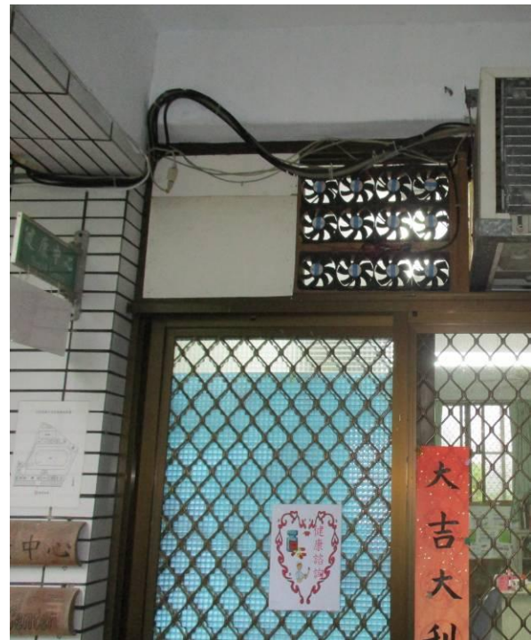
健康中心的太陽能小風扇，小兵立大功，有效改善通風情形，減低室溫，
